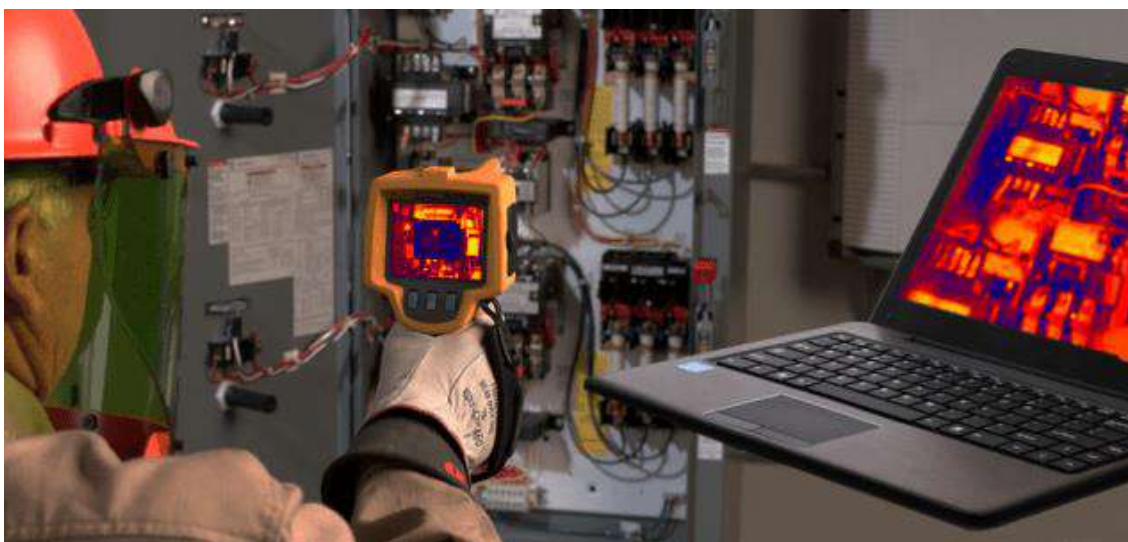
Рисунок 20. Пример проведения тепловизионного контроля электрошкафа
