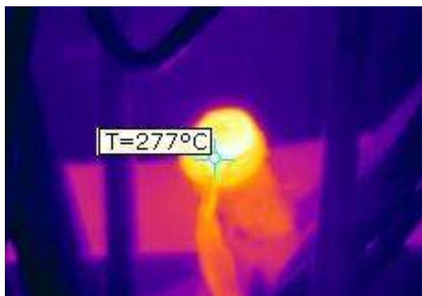
Рисунок 22. Пример обнаружения пожароопасного разогрева болтового контактного соединения
